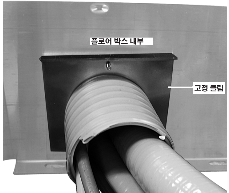
그림 80. 원격 플로어 박스 내부에 고정 클립 부착
