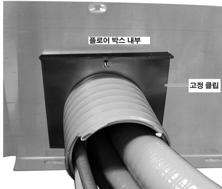
그림 72. 원격 플로어 박스 내부에 고정 클립 부착
