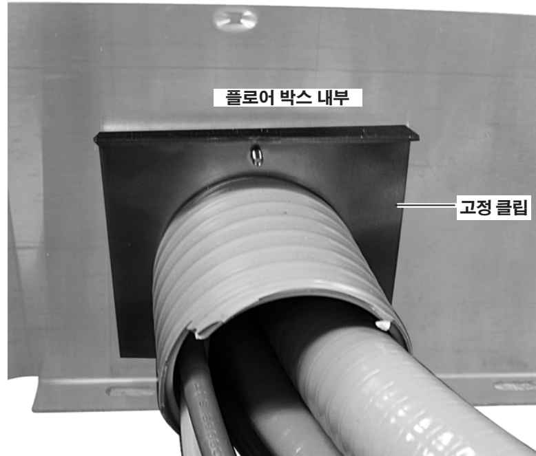
그림 75. 원격 플로어 박스 내부에 고정 클립 부착
