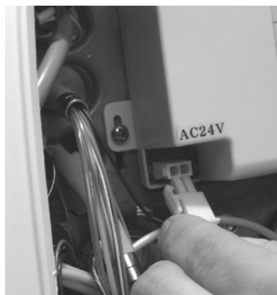
Figura 27. Collegare l'alimentazione CA
